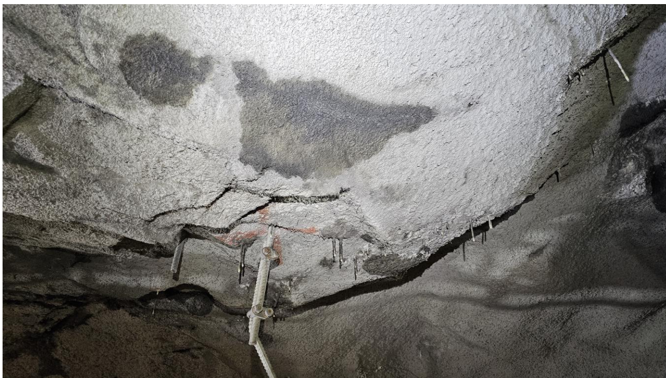
Foto 6. Pel 135. Kalkutfelling i sprøytebetong.
