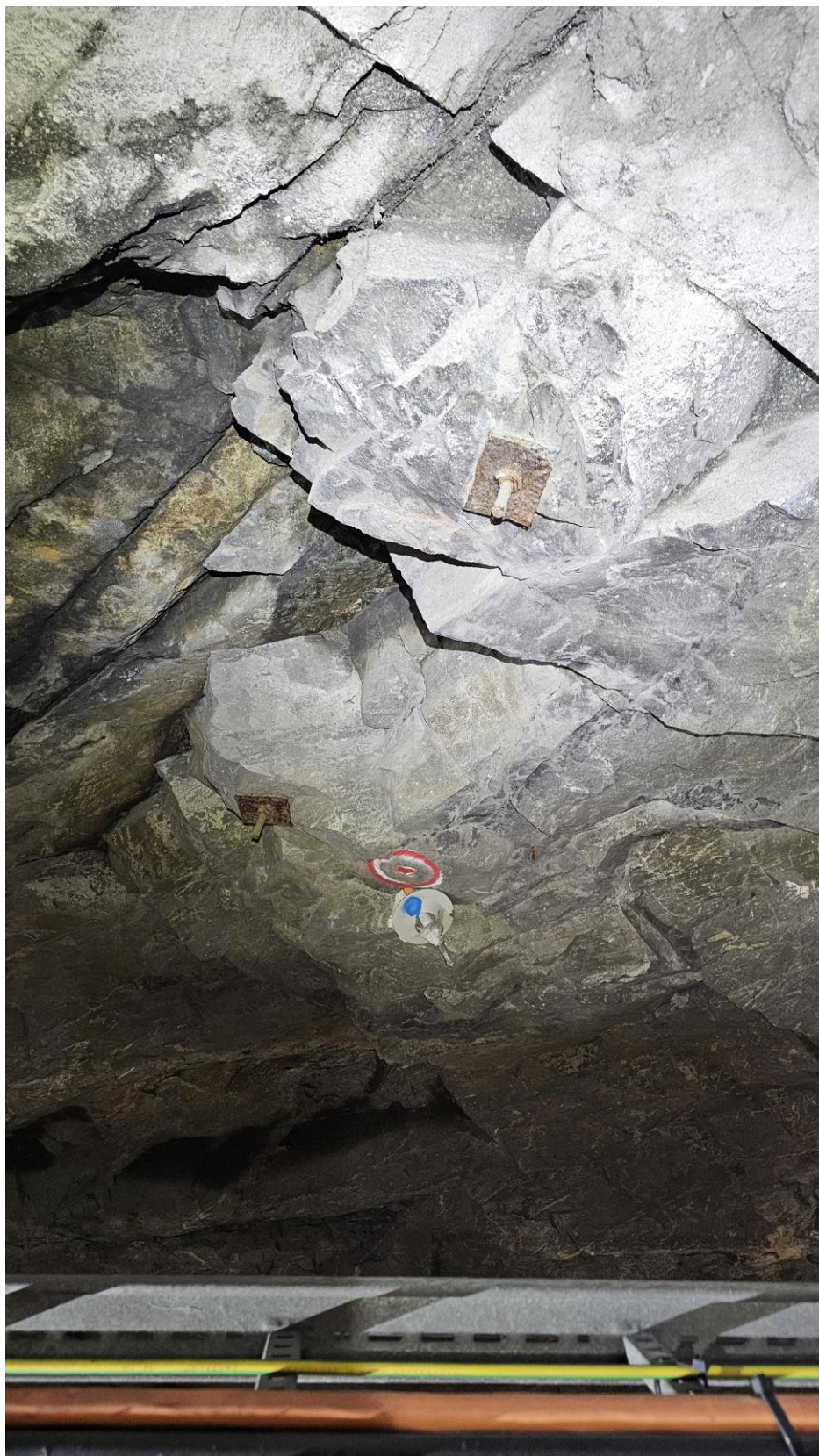
Foto 9. Pel 185. Eksempel på bolt montert etter forrige hovedinspeksjon. Korrodert bolt med firkantplate er trolig fra tunnelen ble drevet i 1964.
