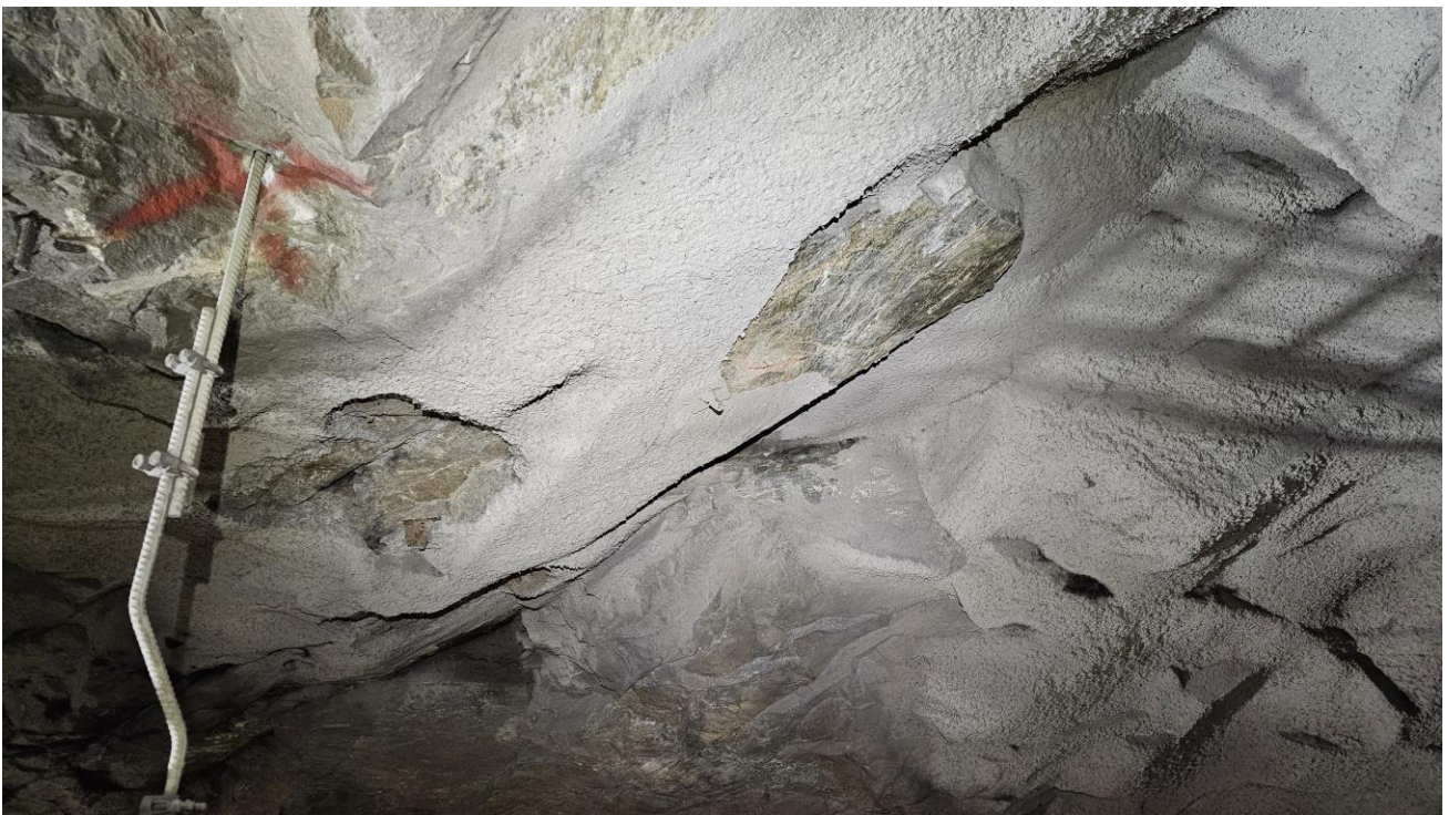
Foto 8. Pel 160. Avskalling av sprøytebetong
